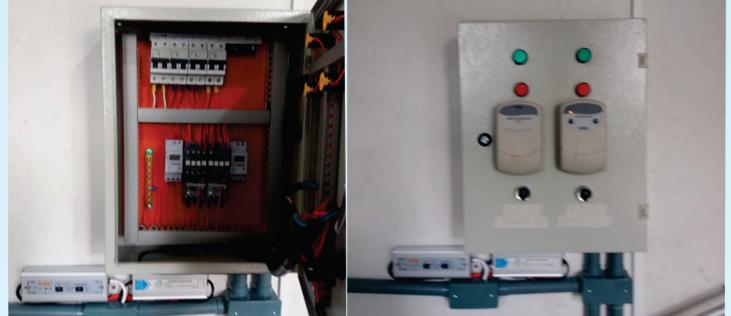
Concluídos a reforma da parte elétrica da casa de máquinas da piscina, com instalação de novos eletrodutos, quadro elétrico, relés, contatores e dispositivos para adequar as instalações as normas de segurança. Também foram instalados os componentes para a nova iluminação da piscina em sistema de leds RGB colorido, para além de proporcionar um visual muito mais agradável, trazer mais segurança aos frequentadores e redução no consumo de energia elétrica.
